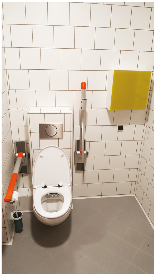
Fotografia 7. Toaleta z funkcją mycia. Zapewniona strefa przesiadania się z wózka i regulowane pochwyt.
